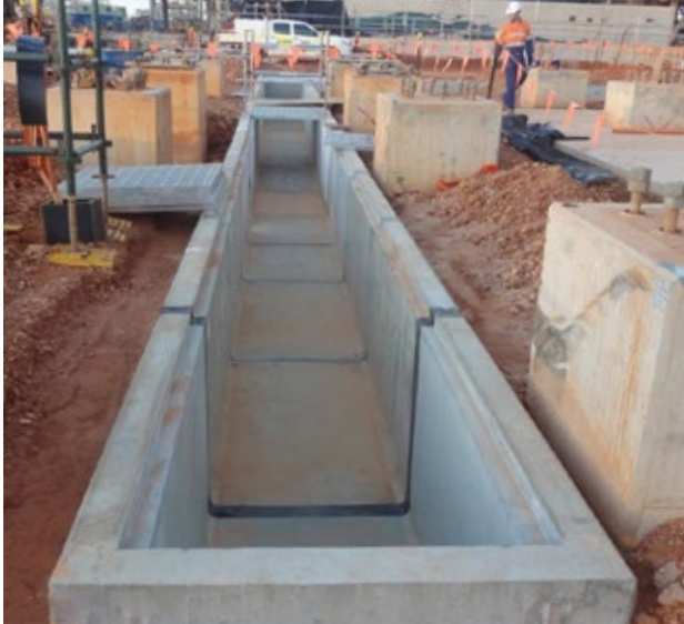
Precast units for LNG processing train
